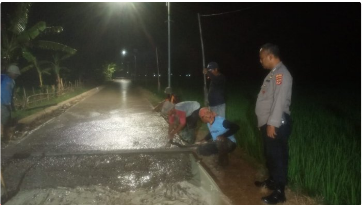
Bhabinkamtibmas Polsek Sliyeg Monitoring Pembangunan Pengecoran Jalan Desa
