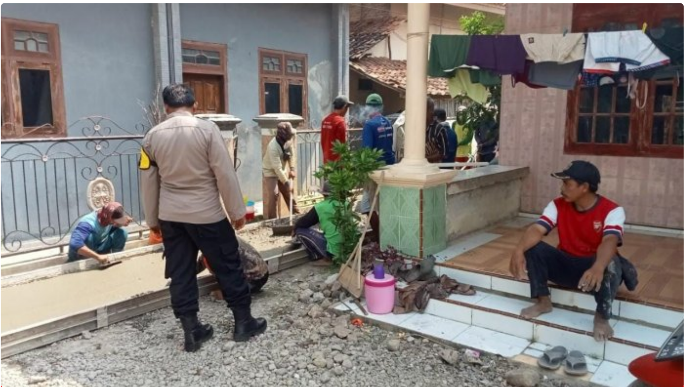
Bhabinkamtibmas Polsek Lohbener Memantau Progres Pembangunan Jalan Setapak
